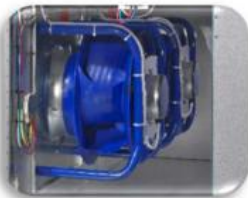
Figur 1 Kammervifte med integrert IE5, EC-motor 2023
